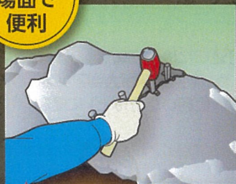
1 庭石の解体に
