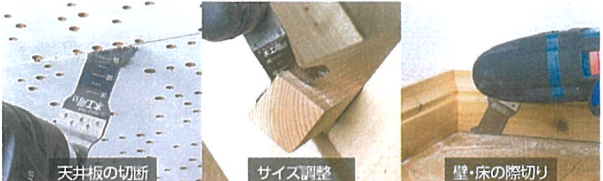
天井板の切断
